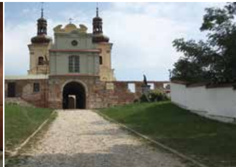
fot. 3. Klasztor w Bieniszewie w remoncie, budynek bramny - stan z sierpnia 2018 r. [fot. archiwum autorki]
